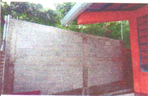
Foto 5: Reparación de muro perimetral
