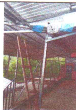
Foto 4: Reparación de canales y bajadas de aguas pluviales
