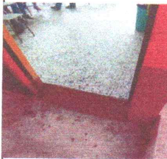
Foto 2: Sustitución de piso por piso de granito
